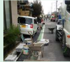
側溝改修(南部コミセン前)
