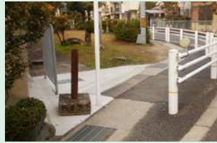
歩行者の待機場所改修(富野小正門前)
