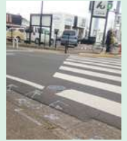
段差解消(市役所北側)
