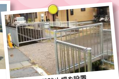
転落防止柵を設置
