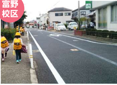
車のスピード抑制のためにセンターラインを消し、路側線を両側に引き直し。
