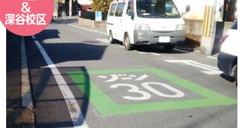
スピードを出して走行する車が多い生活道路や住宅区域を30km/h以下での走行を促すマークを路面表示。
